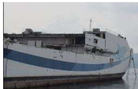
江田島で解体中の「おがさわら」
