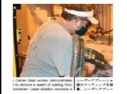
古い塗装の剥離作業などにレーザー装置を使おう、という提言です。従来のグラインダーなどの騒音による聴覚障害や振動による手のしびれ、破片による被害などは防止できそうで、乗員の安全衛生上は優れています。作業後の塗料の付着性も優れているということです。米海軍はまだ正式採用はしていませんが、採用に向けての動きがあります。米海軍が躊躇している理由は、コスト面とレーザーの母材に対する影響とのことですが、陸軍と空軍は既に採用しています。プロシーディングス誌2月号から(下線は訳者)。                                                                                                                                             | 岩崎洋一  |
