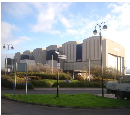
写真⑤ BAEシステムズ社潜水艦建造工場
